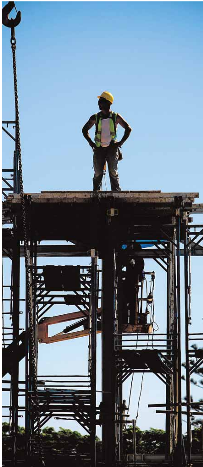
Un obrero observa el horizonte desde el esqueleto de un edificio. :: LA VOZ
